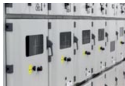
Prévention des risques de court-circuit et d'échauffement
